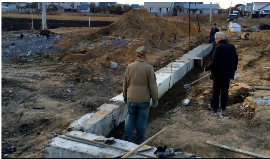
Рис. 5. Устройство здания из ранее использованных железобетонных колонн
