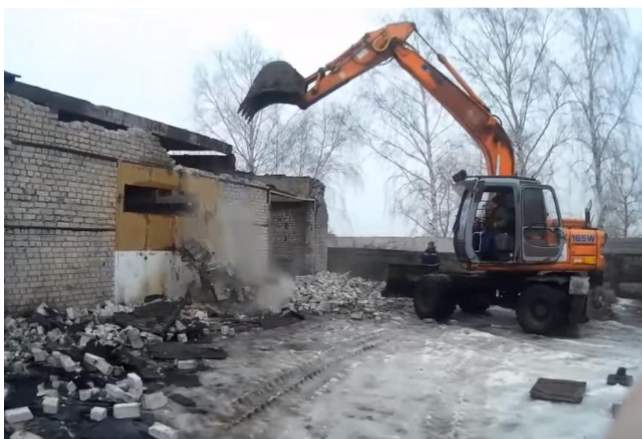
Рис. 4. Рациональный снос здания
