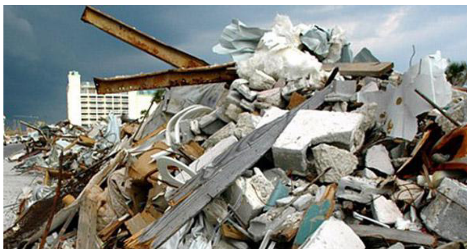
Рис. 1. Варварский снос здания методом обрушения строительных конструкций
