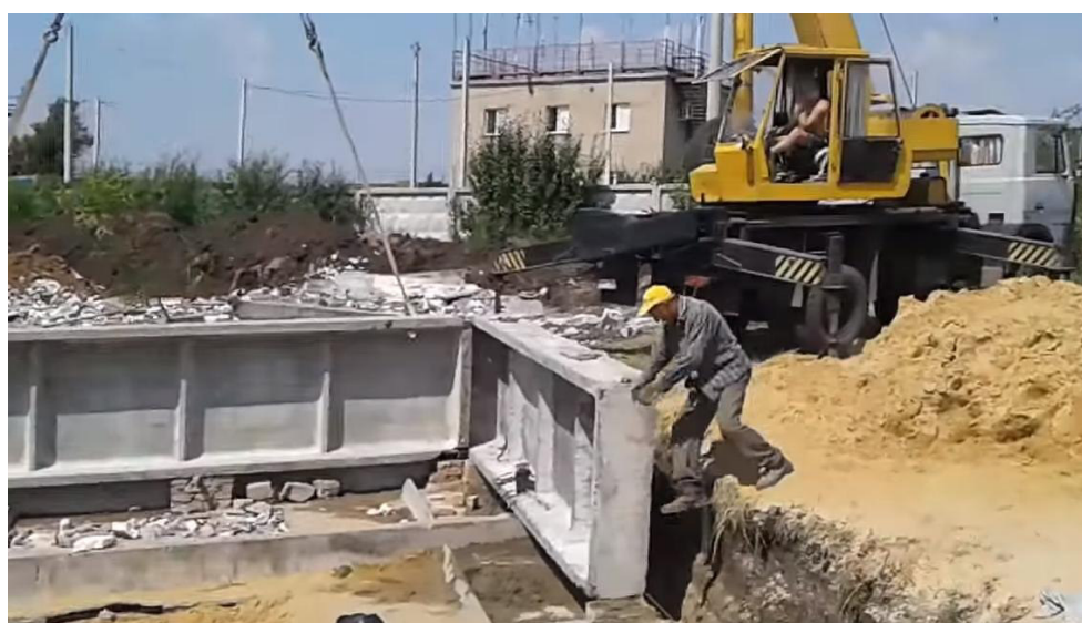
Рис. 6. Устройство плитного фундамента из ранее использованных железобетонных конструкций на местности с высоким уровнем грунтовых вод
