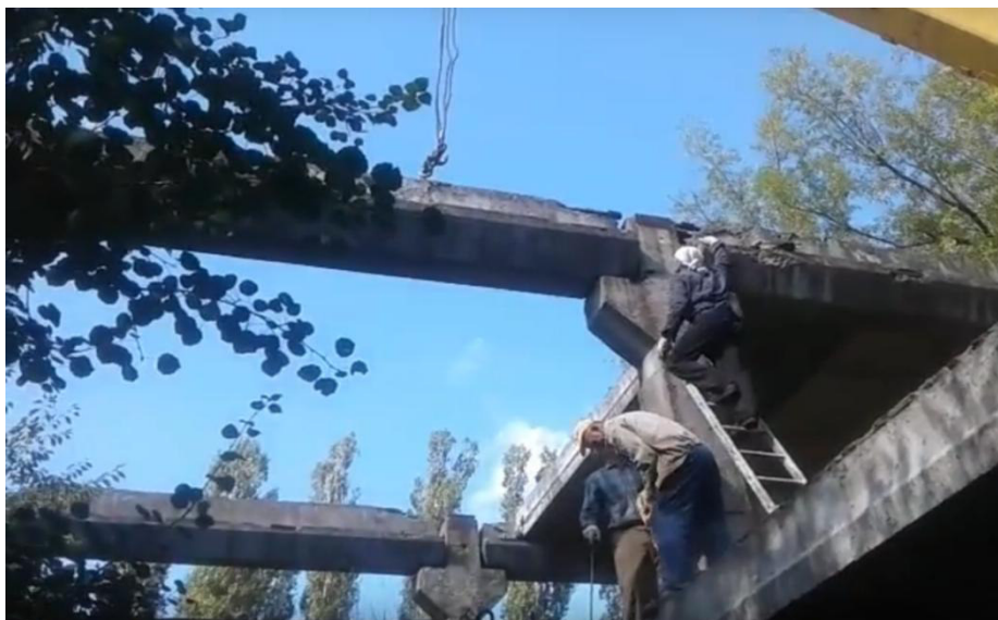
Рис. 3. Демонтаж здания методом поэлементной разборки
