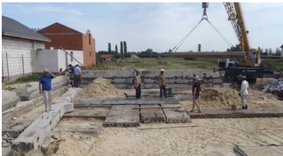
Рис. 6. Устройство плитного фундамента из ранее использованных железобетонных конструкций на местности с высоким уровнем грунтовых вод
