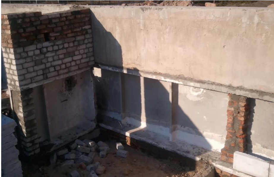
Рис. 8. Устройство стен подвала из ранее использованных железобетонных плит
